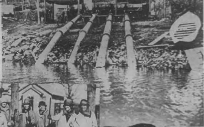
Una de las poderosas bombas que se están utilizando para desecar el lago Nemi, cerca de Roma, con el fin de extraer el famoso tesoro de la antigua galera romana hundida en tiempos de Tiberio. Los trabajos de desecación, que han sido ordenados por el premier Mussolini, van ya muy adelantados, pues con ellos se ha logrado rebajar, en tres metros, el nivel del lago.
